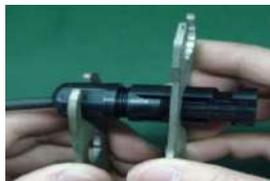
**Passaggio 4** : verificare la corretta polarità del cavo di collegamento dai moduli FV e dei connettori di ingresso FV. Quindi, collegare il polo positivo (+) del cavo di collegamento al polo positivo (+) del connettore di ingresso FV. Collegare il polo negativo (-) del cavo di collegamento al polo negativo (-) del connettore di ingresso FV.
